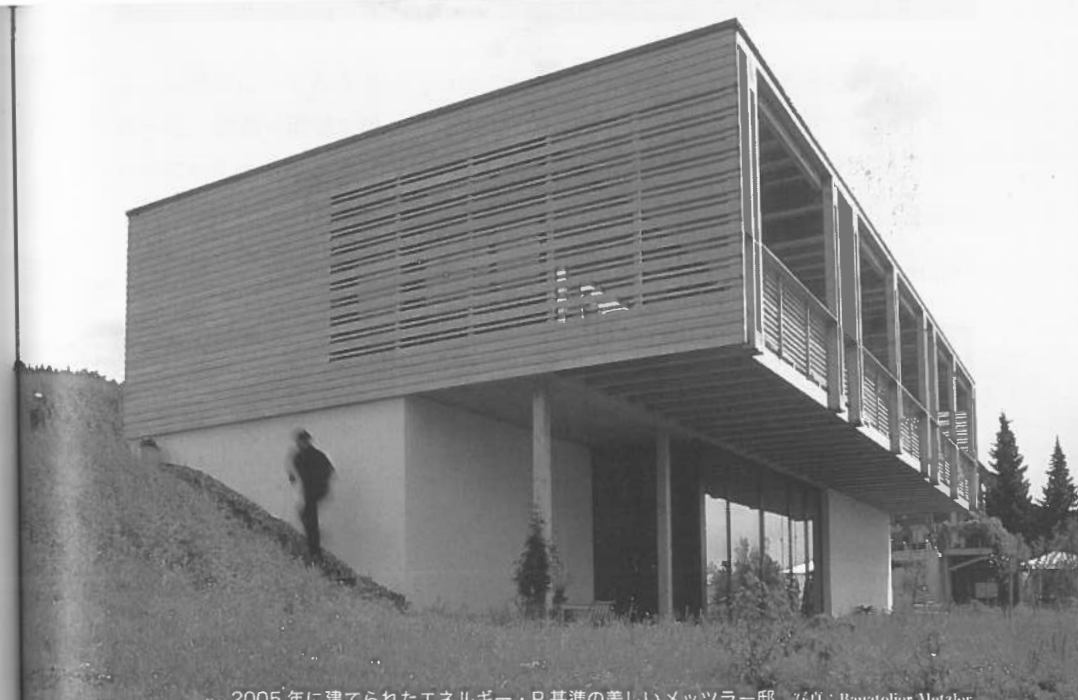
2005年に建てられたエネルギー・P基準の美しいメツラー邸。写真：Bauatelier Metzler
